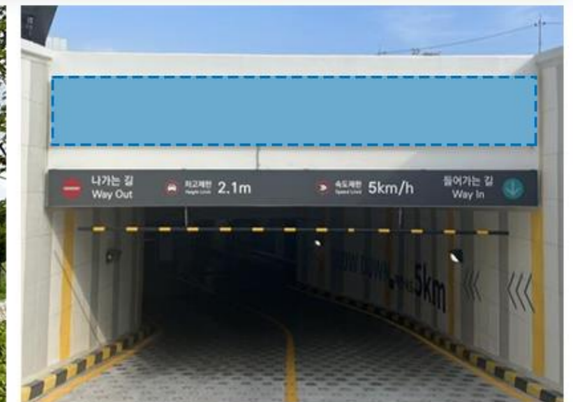
지하주차장 입구상단 벽부
