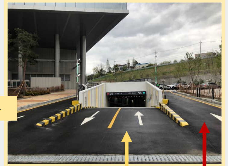
지하주차장 입구 (일반차량)
